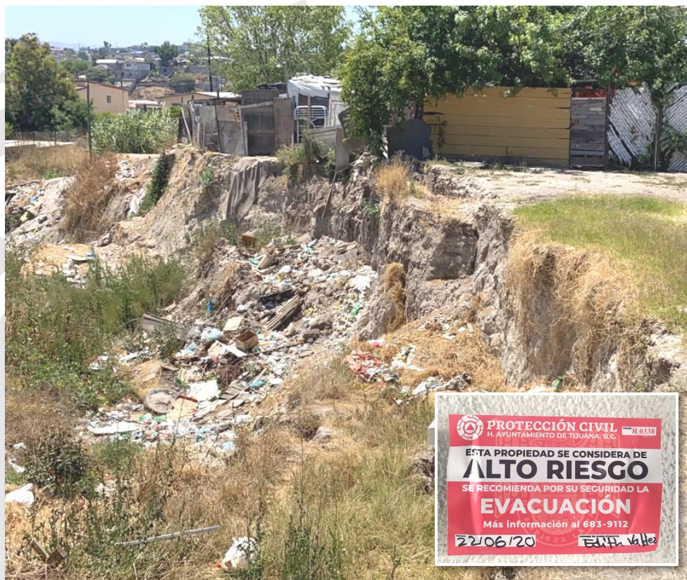
ZONA DE RIESGO. Viviendas irregulares con alto riesgo.
